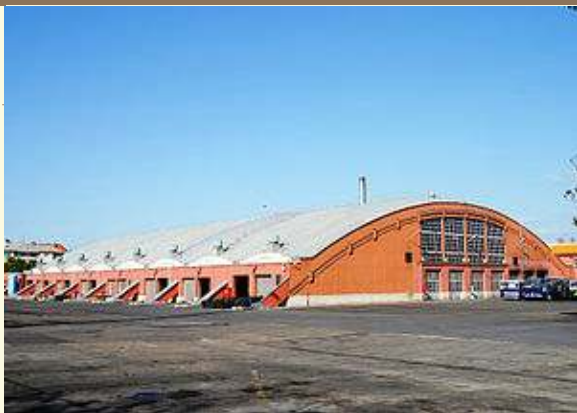
A Beszárkó Hamzsabégi úti buszgarázs szerelőcsarnoka („Fűst garázs”) 1938 és 41 között épült. Akkor a 82 méteres nyílásközü héjszerkezet világosúcsnak számított! 71 (Építészeti tervét Padányi Gulvász Jenő, a statikai terveket Dr. Menyhárd István készítette)
